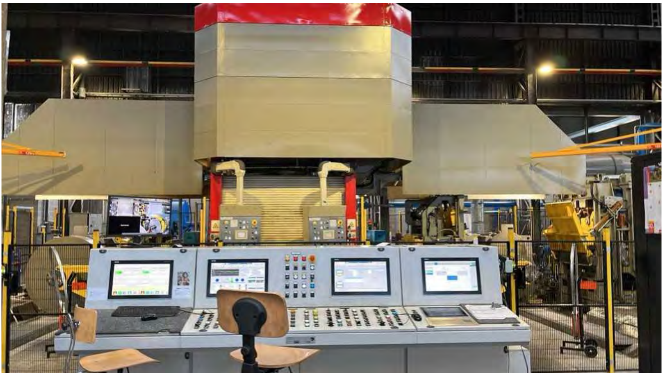
Oggiono plant - MINO 800 rolling mill
